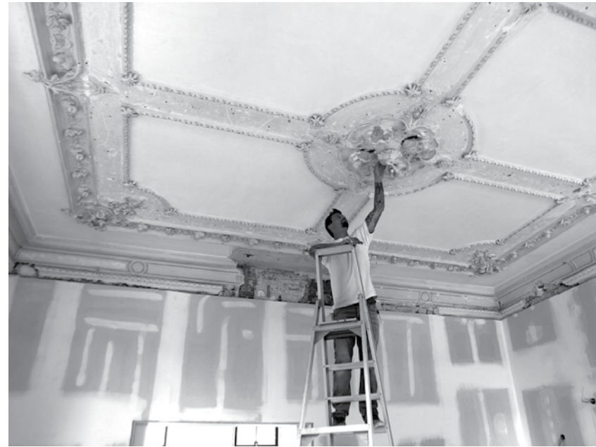
De ornamenten van de plafonds in Huize Holland worden in oude luister hersteld.
